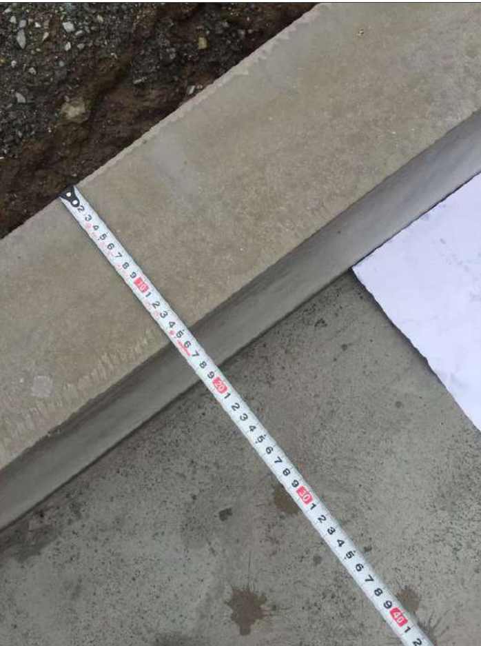
2-18 基礎立ち上りの幅150mm以上か確認する。(1/2)
