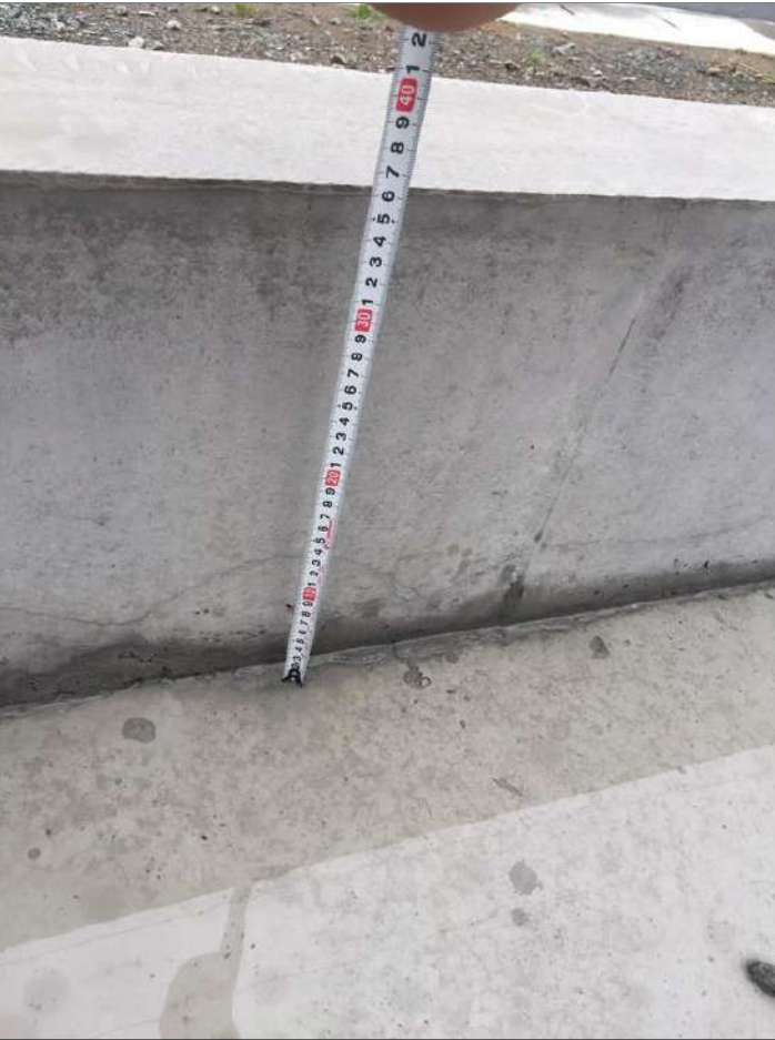
2-18 基礎立ち上りの幅150mm以上か確認する。(1/2)
